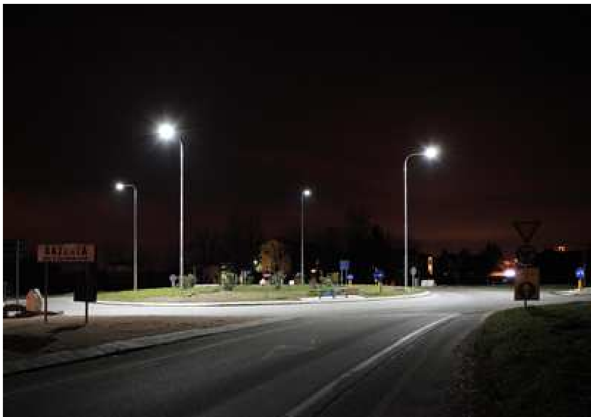
Esempio illuminazione rotatoria con apparecchi di illuminazione a LED.
