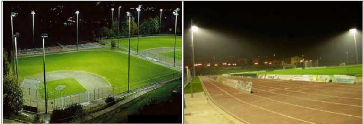
Fig. 7.9.1 Impianti sportivi illuminati in modo conforme alla L.R. n.17/2009 con proiettori asimmetrici orientati orizzontalmente e che non disperdono luce verso l'alto.
